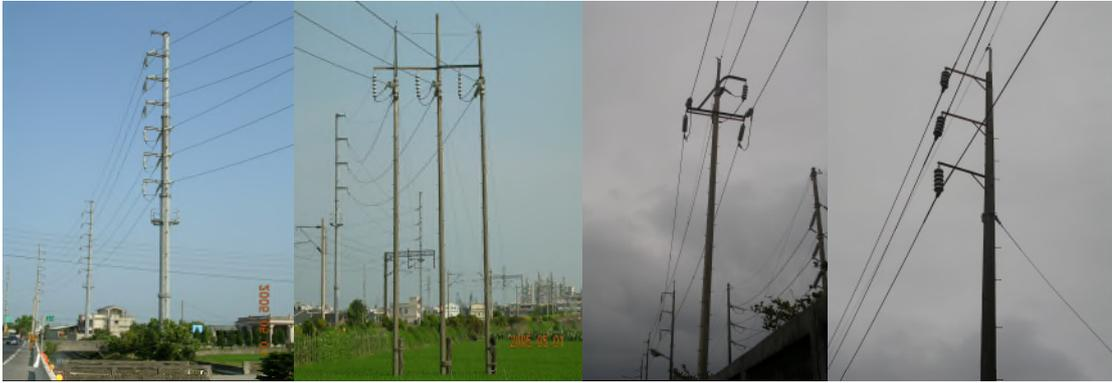
圖 2-5 電桿型支持物外觀(大部份用於 69 千伏)
