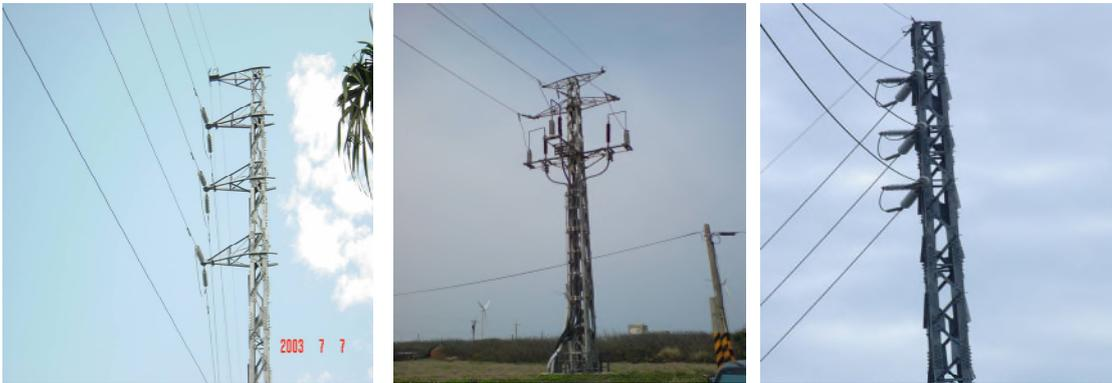
圖 2-6 鐵柱型支持物外觀(大部份用於 69 千伏)
