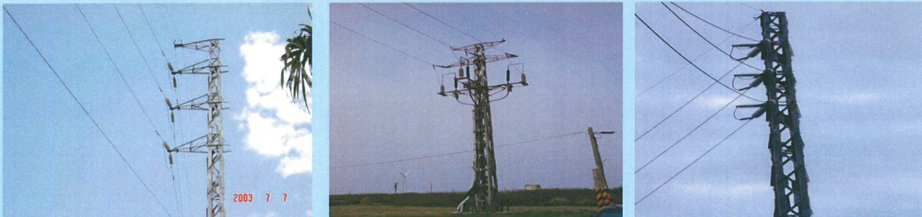
鐵柱型支持物外觀(大部分用用於69仟伏)
