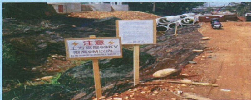
工地豎立警示牌
